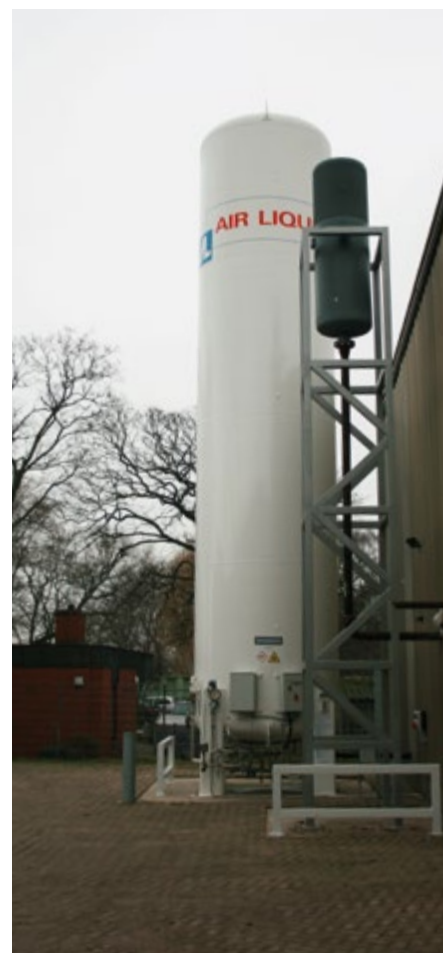
Der Außentank neben der Halle
